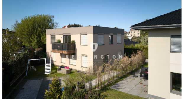
Außenansicht Haus Q
