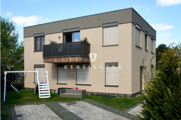
Außenansicht Haus Q
